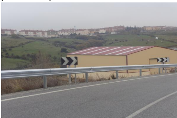
Guardarraíl recientemente instalado en nuestro municipio.
